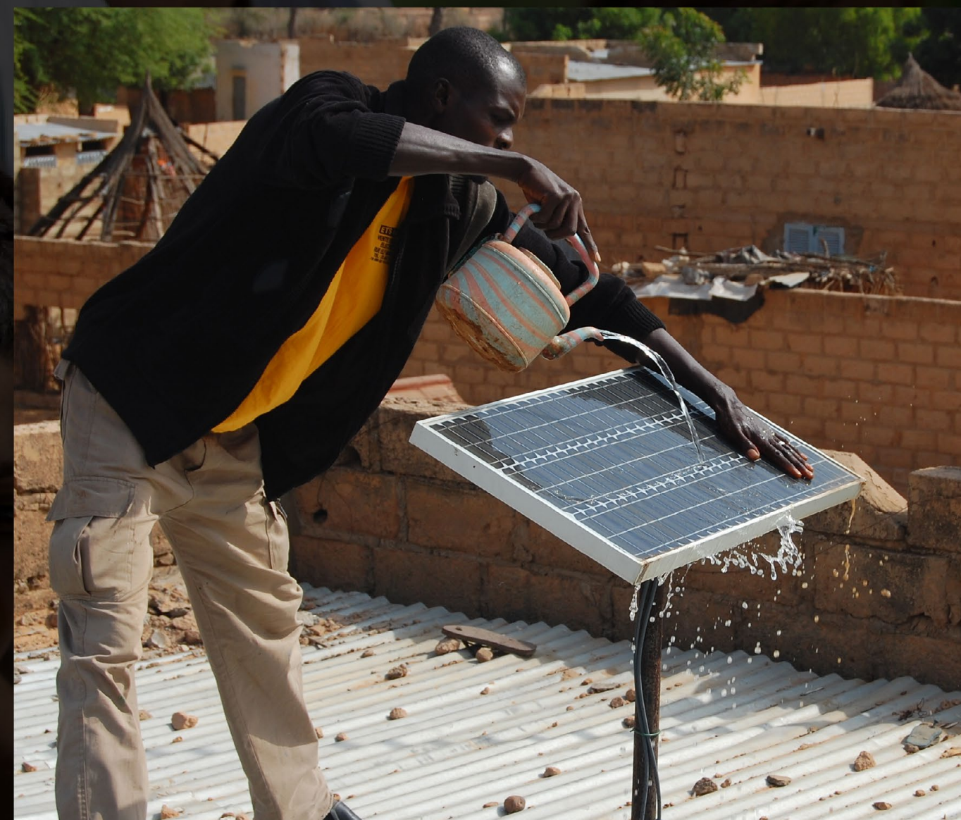
Installation de panneaux photovoltaïques dans les écoles afin de charger des lampes solaires en Afrique et dans les îles francophones
