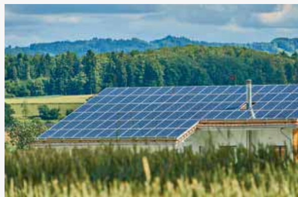
Photo : installation de SolarX.
