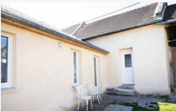
Photo : Réseau Éco-Habitat ; maison avant et après rénovation.
