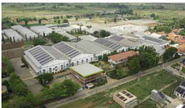
Indonésie : Installation panneaux solaires sur une toiture. © Xurya Daya Indonésie
