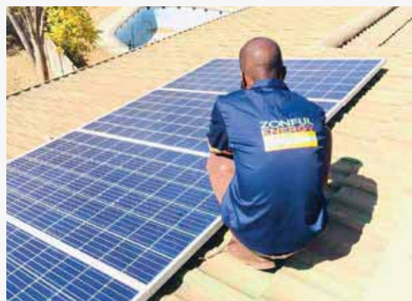
Photo : Zonful ; installation de panneaux solaires.
